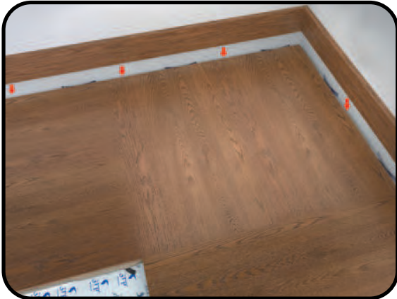
Wall installation sample with covering hooks and auction perimeter. / Ejemplo de Instalación en pared con enganches de revestimiento y remate perimetral. / Esempio di posa in parete con clips rivestimento e profilo di chiusura perimetrale. / Exemple d'installation avec crochets et plinthe per fixation murale.
