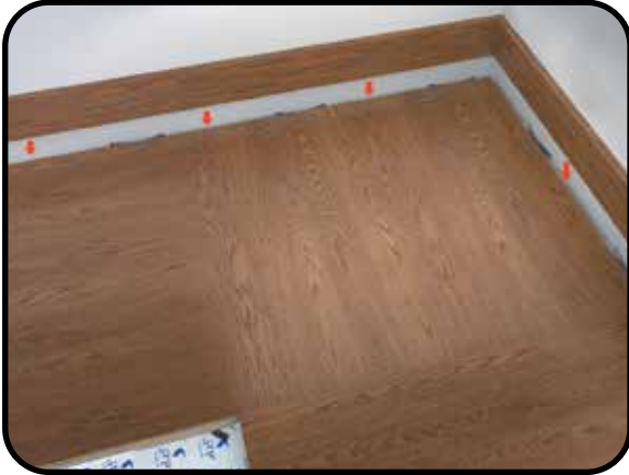
Wall installation sample with covering hooks and auction perimeter. / Ejemplo de instalación en pared con enganches de revestimiento y remate perimetral. / Esempio di posa in parete con clips rivestimento e profilo di chiusura perimetrale. / Exemple d'installation avec crochets et plinthe pour fixation murale.
