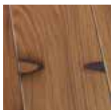
Pièce de bois pour reboucher les trous de chevilles Wood pieces to fill dowel holes
