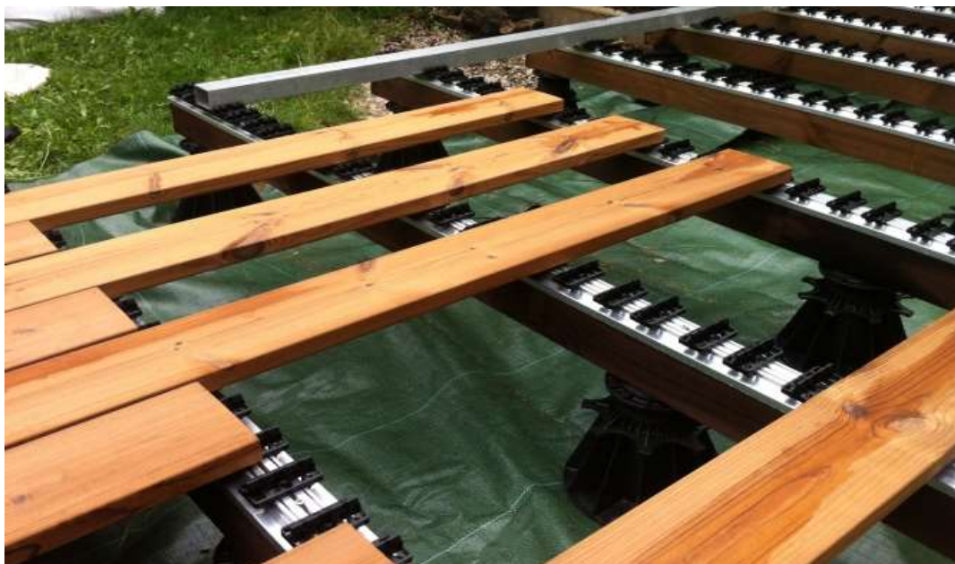
Figura 6: in alto , sottostruttura KIT 50 inserita su un elemento strutturale di larghezza 60 mm (foto Grad™)
